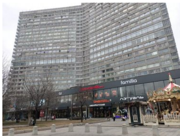
Фото 4. Внешний вид здания
