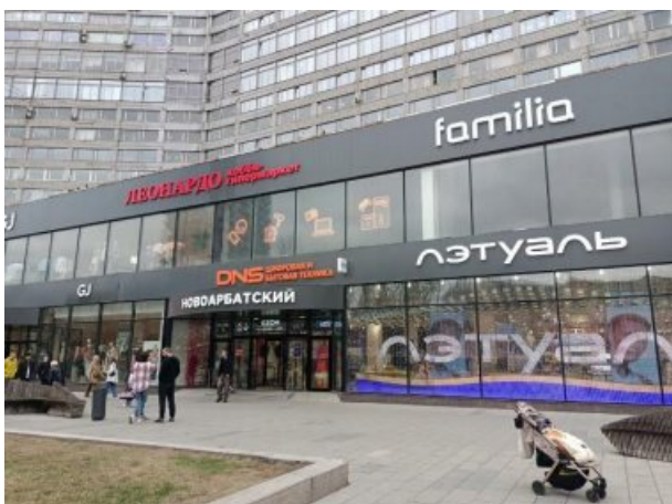
Фото 3. Внешний вид здания
