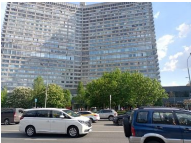
Фото 1. Внешний вид здания
