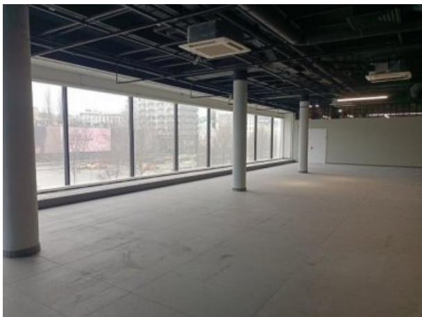
Фото 19. Состояние помещений на 2 этаже
