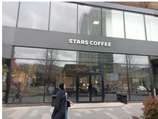
Фото 2. Внешний вид здания
