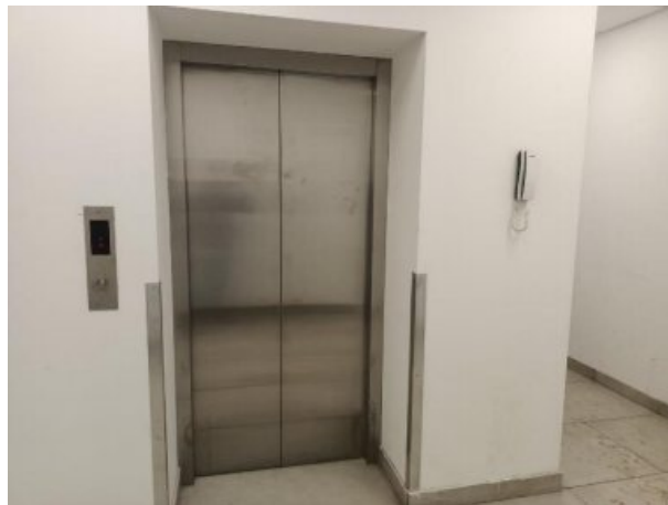
Фото 26. Состояние помещений -2 этаж
